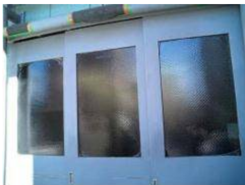
窓ガラス艶面表側より水貼り施工
