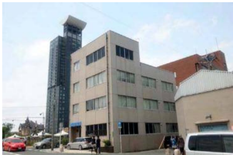
1F.4F 内貼り施工中のビル(北九市門司区)
