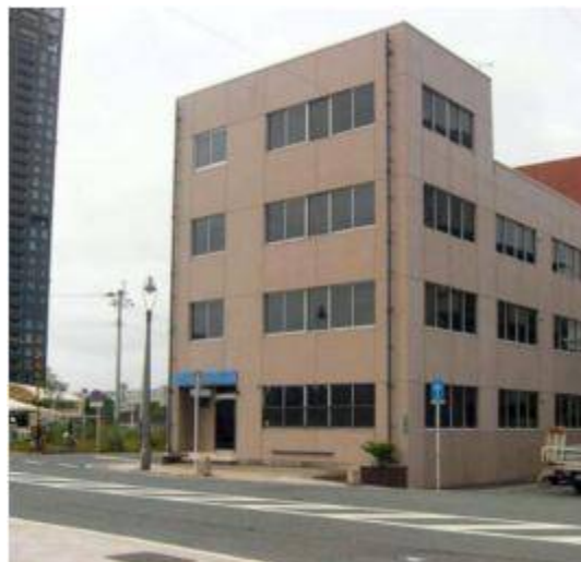
全フロア施工完了の(株)マシン商会ビル
